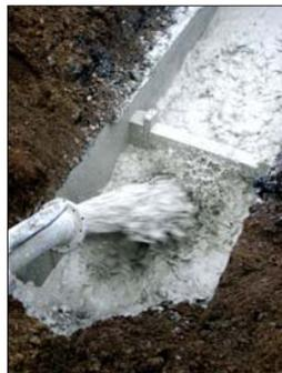
Befüllung des Schlitzes mit Bentonit-suspension (Dichtwand)
