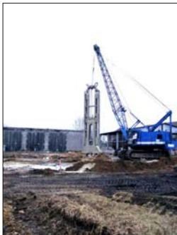
Bodenaushub mit Schlitzwandgreifer
