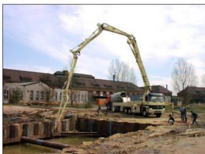
Einbau der Unterwasserbetonsohle
